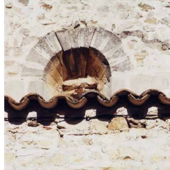
Claveaux de fenêtre descendus à Saint Martin les Eaux probable suite au séisme de 1708.
